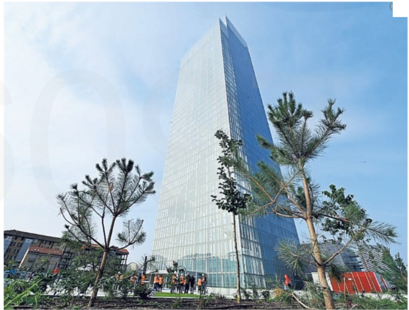
▲ Cantiere lumaca Il grattacielo Piemonte inaugurato il 14 ottobre
