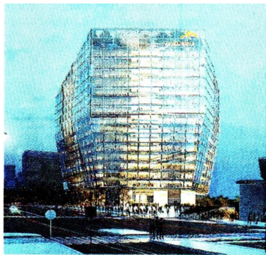
Commesse in Lussemburgo. La sede di Arcelor Mittal
