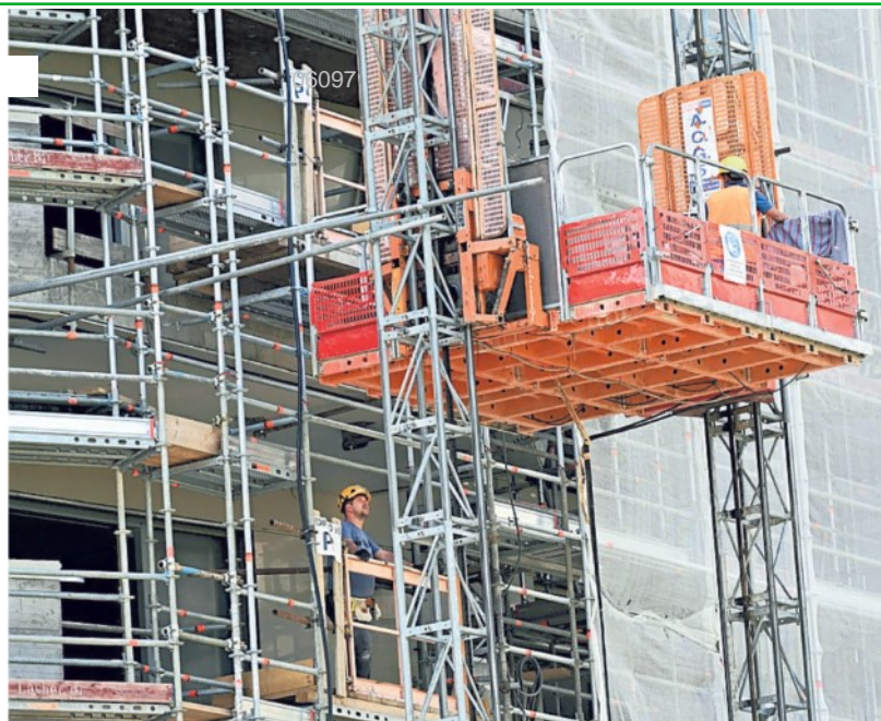
Un cantiere edile
