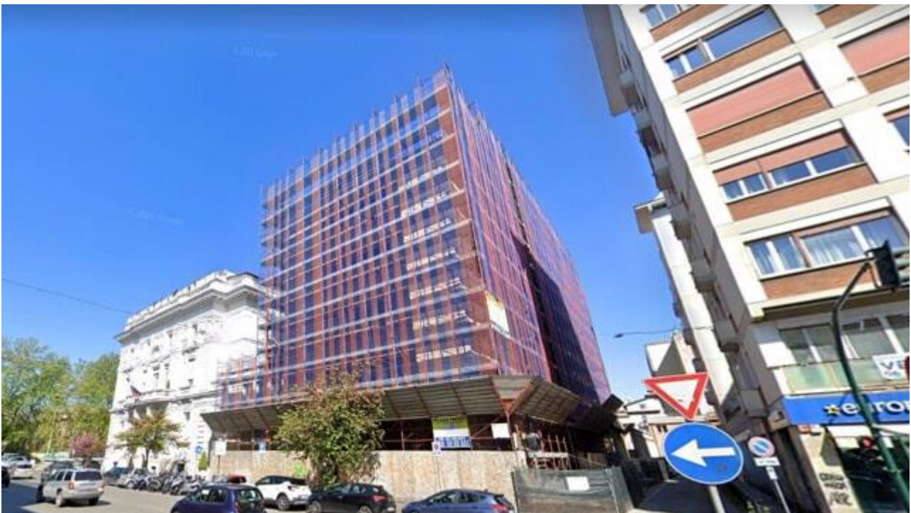
L'edificio anni '50 in via Luisa di Savoia poco prima della demolizione
